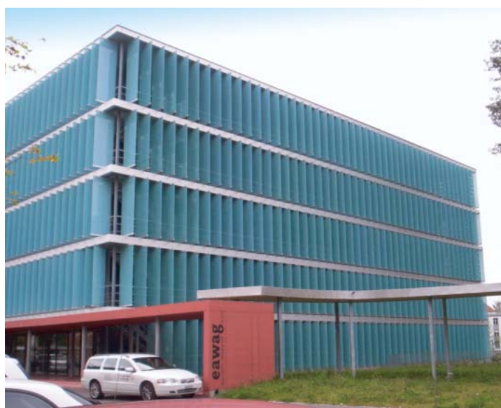
Vista exterior del Forum Chriesbach. Paneles automatizados móviles de vidrio serigrafado que proporcionan adaptación a las condiciones externas. Foto: R. Valdivia S.
